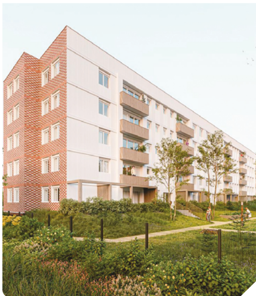
Nouvelle résidence dans le quartier des Aviateurs à Lille
