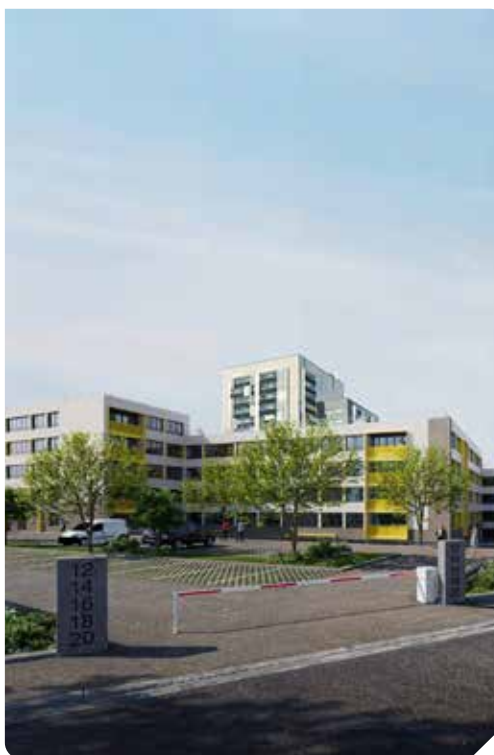
À Villemomble, suite à sa reprise par Vilogia, la résidence Benoni connaît une réhabilitation et une résidentialisation complète, avec plus de 90 000 euros investis par logement.
