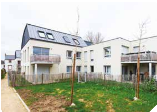
Résidence Clos Saint-Gildas à Grandchamp-des-Fontaines : une opération mixte alliant neuf et réhabilitation.
