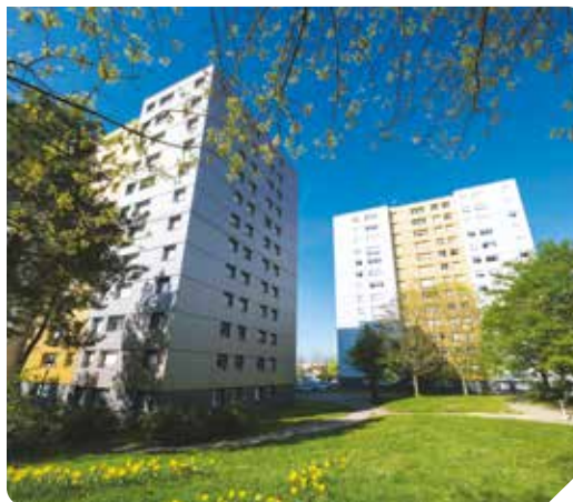
Résidences Aetas et Aureum : une réhabilitation au service du confort des habitants.
