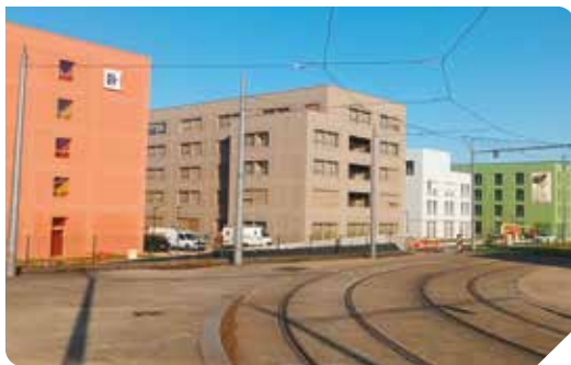
Le campus Porte des Alpes de Bron accueille de nouveaux logements étudiants.
