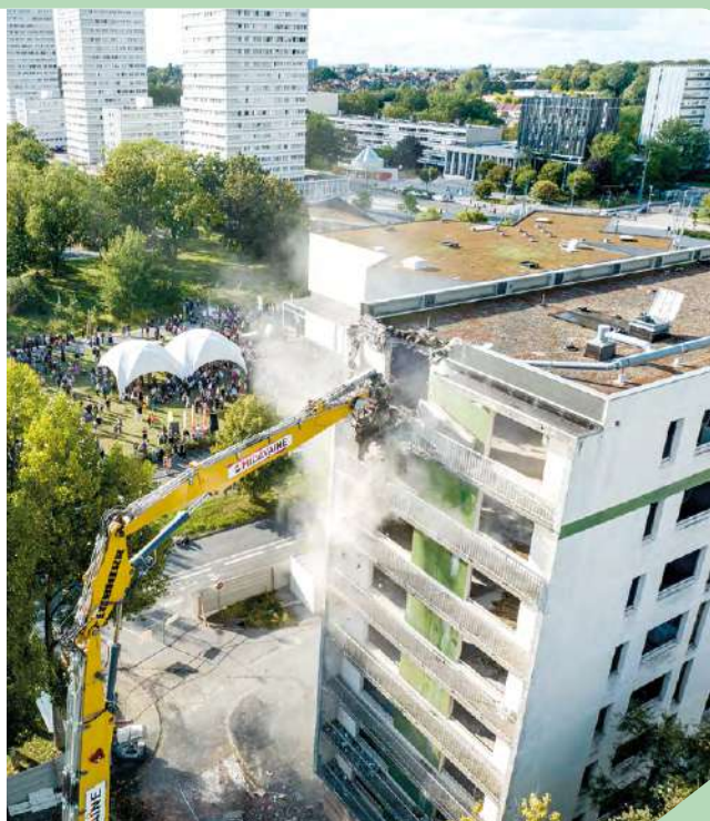
Mons-en-Baroeul, démolition d'une barre d'immeuble
