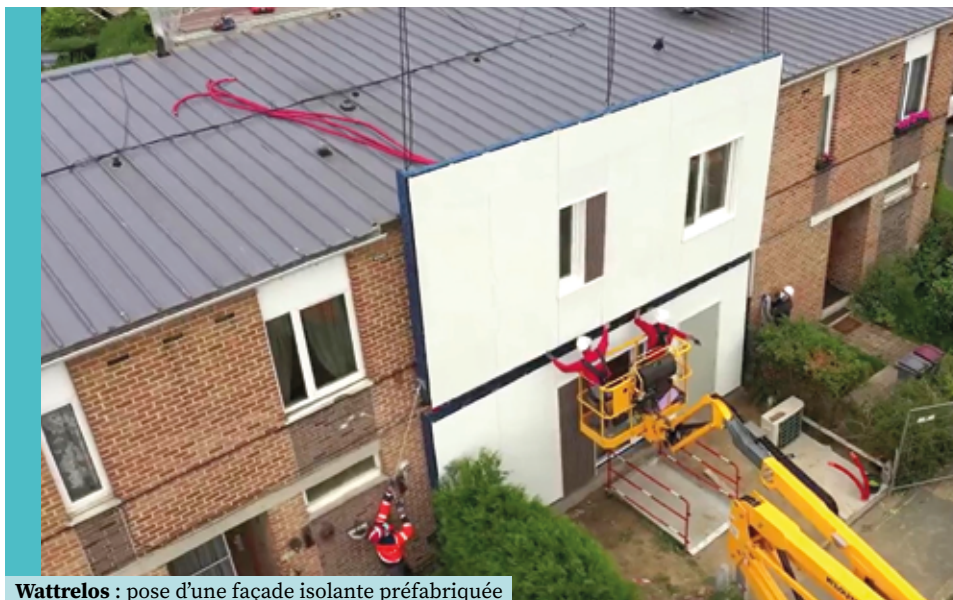
Wattlelos : pose d'une façade isolante préfabriquée dans le cadre de la réhabilitation EnergieSprong
