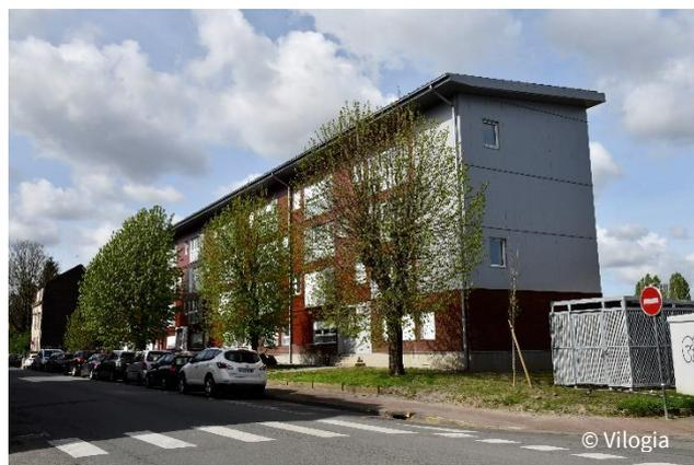
Fabriquées par l'entreprise belge Build Up, les nouvelles façades ont été posées en l'espace de quelques semaines entre fin septembre et fin octobre 2022. Des longrines posées sur des micropieux sont venues les soutenir. De la même manière, la toiture a été recouverte de panneaux isolants préfabriqués. Elle a été réorientée vers le sud avec une inclinaison de 10° pour garantir l'efficacité du dispositif photovoltaïque.
