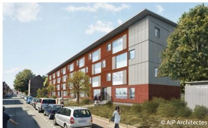
Fabriquées par l'entreprise belge Build Up, les nouvelles façades seront posées en l'espace de quelques semaines entre fin septembre et fin octobre. Des longrines posées sur des micropieux viendront les soutenir. De la même manière, la toiture sera recouverte de panneaux isolants préfabriqués. Elle a été réorientée vers le sud avec une inclinaison de 10° pour garantir l'efficacité du dispositif photovoltaïque.
