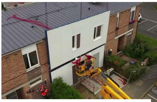
Pose d'une façade isolante préfabriquée à Wattrelos
