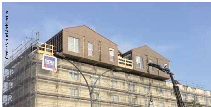
Surélévation d'un immeuble avec 33 logements modulaires à Poissy (78). Maître d'ouvrage : Villogia. Maître d'œuvre : Virtuel Architecture. Entreprise générale : Sicra IDF. Entreprise titulaire du lot « Modules bois » : CMB.
