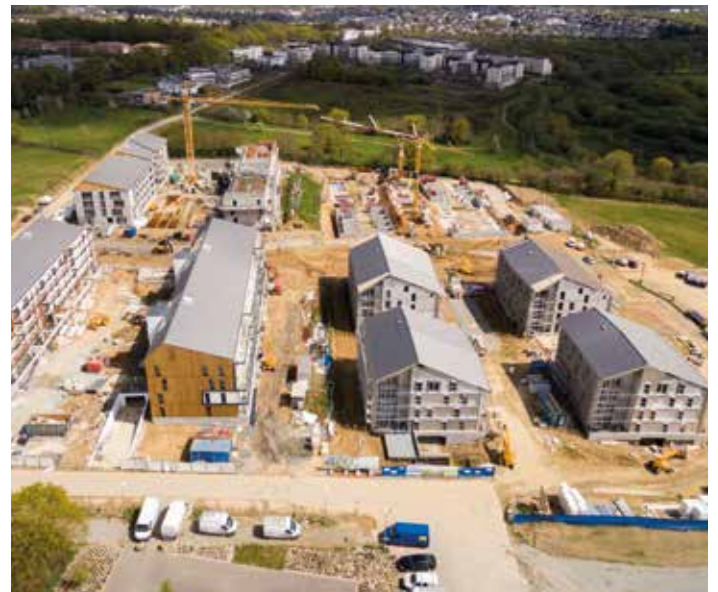
Le programme Soléo sur la ZAC de La Fleuriaye à Carquefou, plus importante opération en France de logements collectifs certifiés PassivHaus, qui proposera au total 300 logements passifs.
