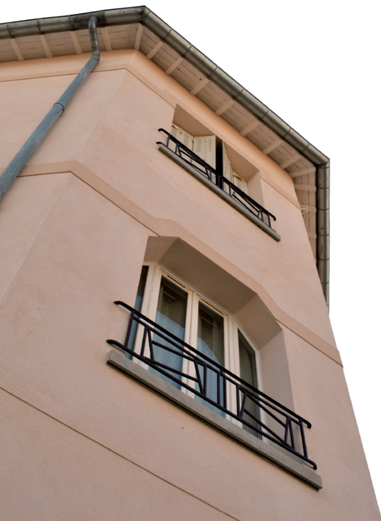
Rue Gabrielle, Drancy (93) Construction de 6 logements
